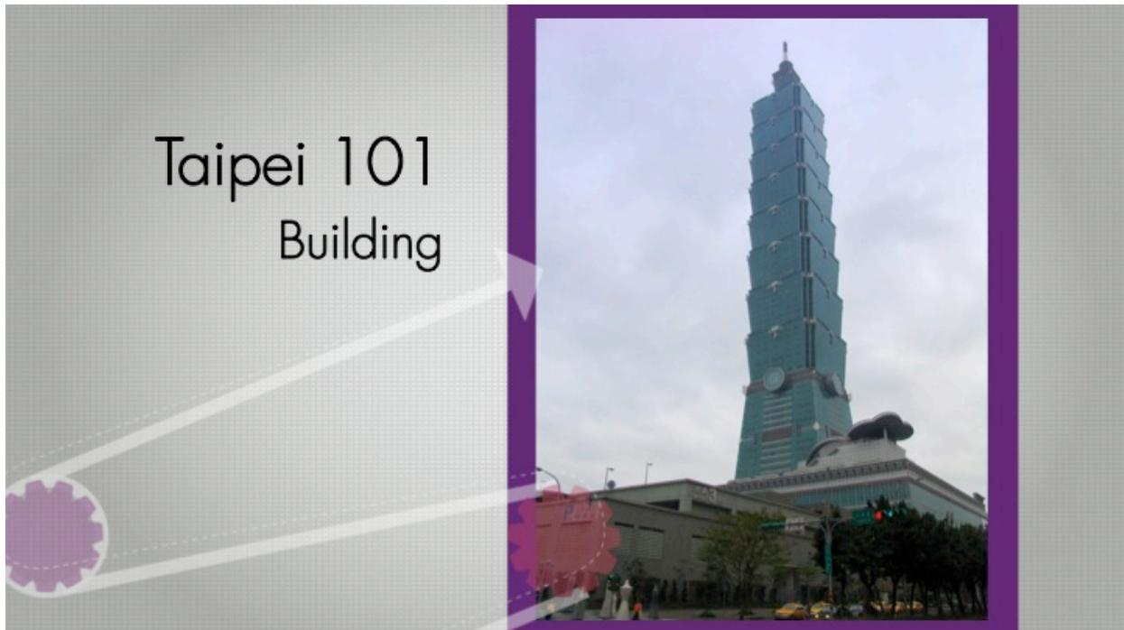
Depuis son ouverture en 2004, la tour est une icône de la Taïwan moderne. Avec ses 101 étages du sol au toit, Taipei 101 est conçu pour résister à des vents de typhons allant jusqu'à 216 kilomètres par heure (134 miles par heure) et pour résister aux tremblements de terre les plus forts qui pourraient se produire durant un cycle de 2500 ans.
